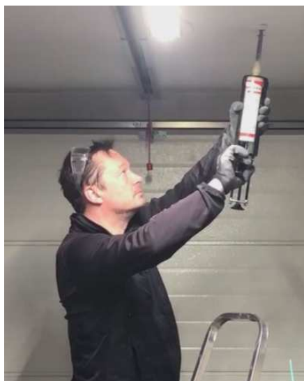
Obr.43, aplikace chemické malty do otvoru, autorské foto
