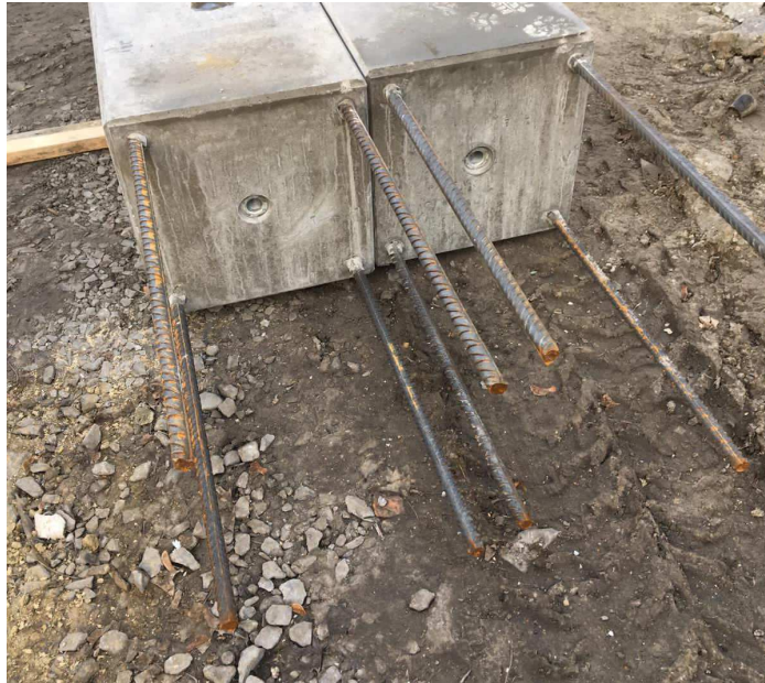
Obr.12, Horní výztuž sloupu, autorské foto
