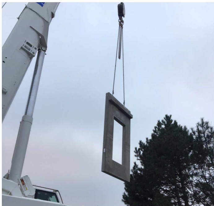
Obr.16, Přemísťování panelu autojeřábem, autorské foto
