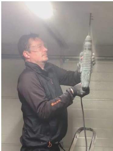
Obr.41, Vyvrtání otvoru, autorské foto
