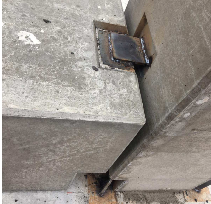
Obr.15, Přivaření základového prahu ke sloupu, autorské foto
