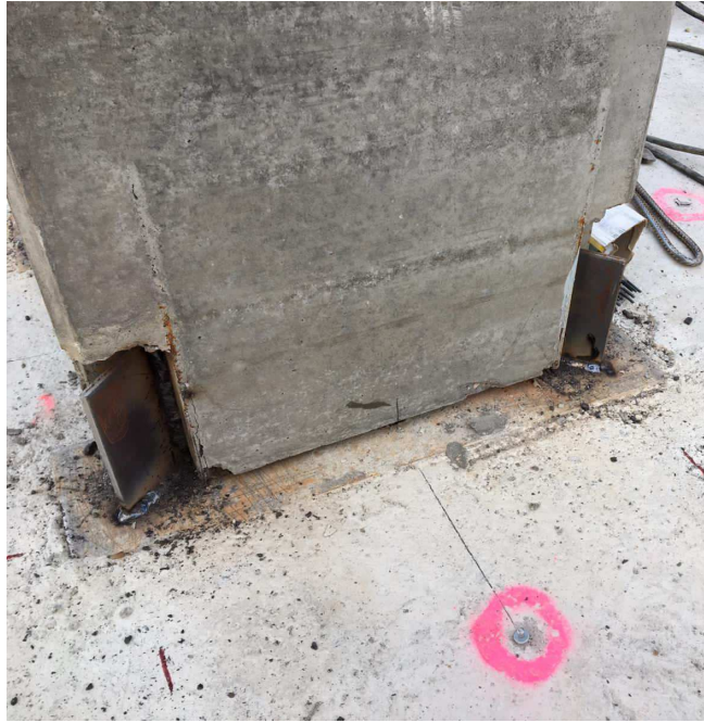
Obr.14, Navaření sloupu k patce, autorské foto
