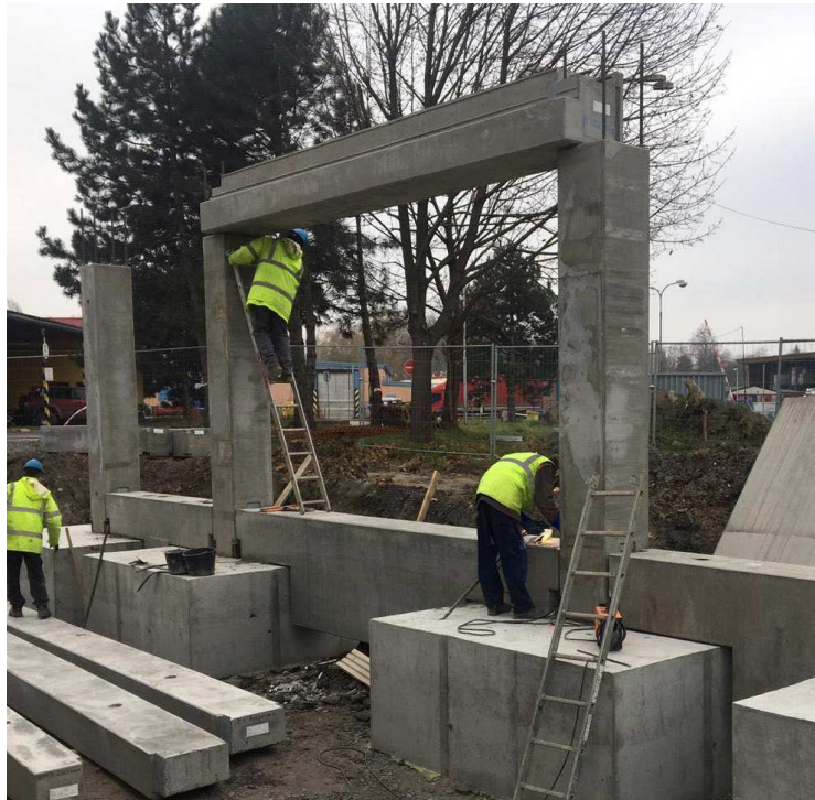
Obr.18, Usazování průvlaku na trny sloupu, autorské foto
