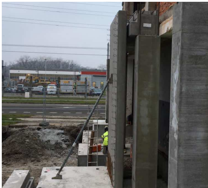
Obr.17, Zapření panelu vzpěrami, autorské foto
