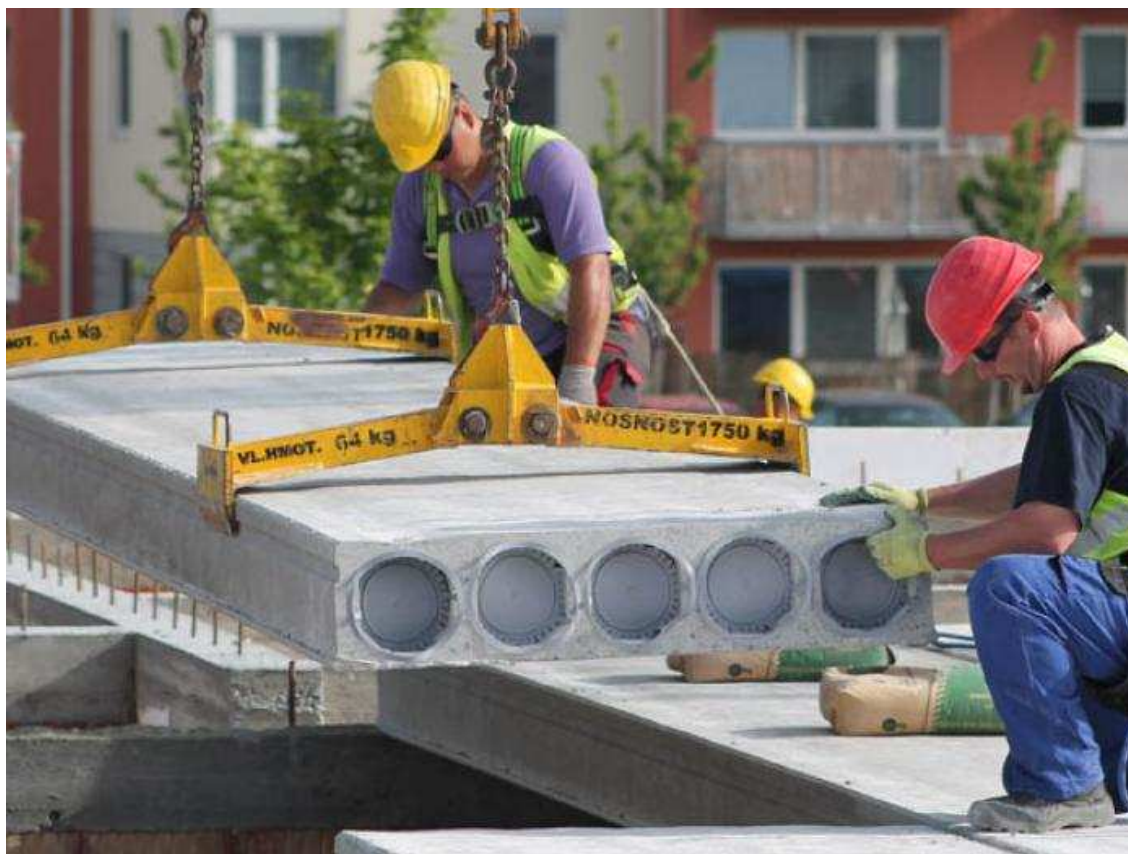
Obr.20, Umísťování stropního panelu Spiroll, www.toposprefa.cz
