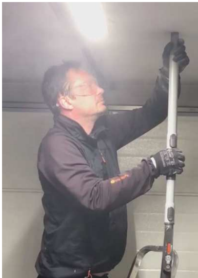
Obr.42, vysátí prachu z otvoru, autorské foto
