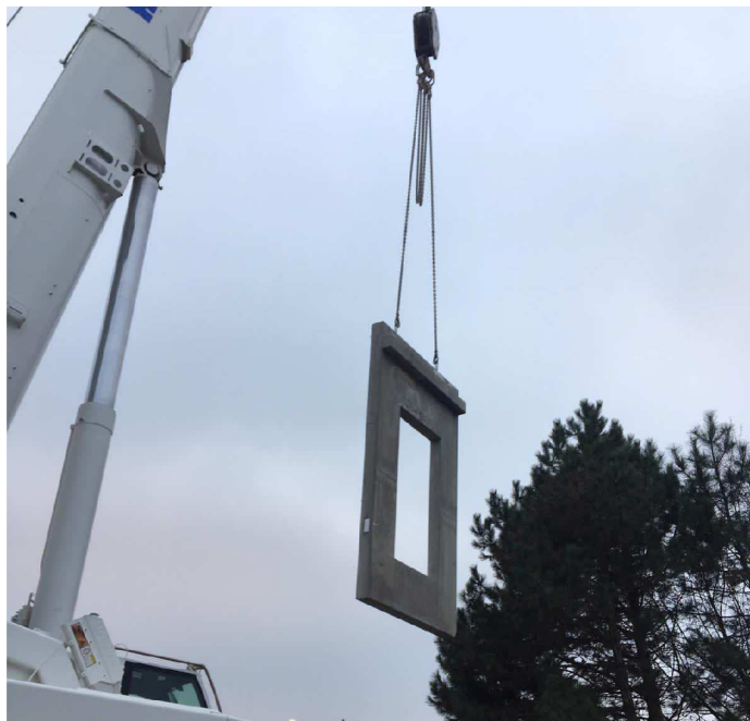
Obr.16, Přemísťování panelu autojeřábem, autorské foto
