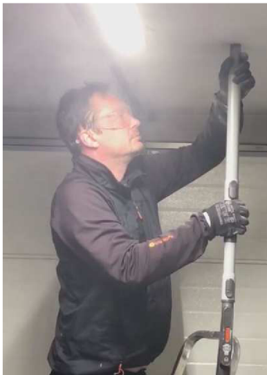
Obr.42, vysátí prachu z otvoru, autorské foto
