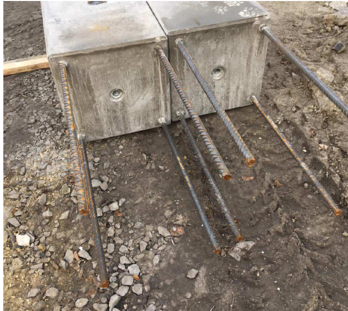
Obr.12, Horní výztuž sloupu, autorské foto
