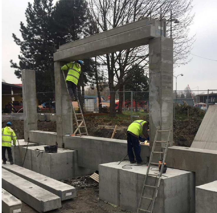
Obr.18, Usazování průvlaku na trny sloupu, autorské foto
