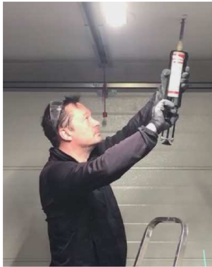
Obr.43, aplikace chemické malty do otvoru, autorské foto
