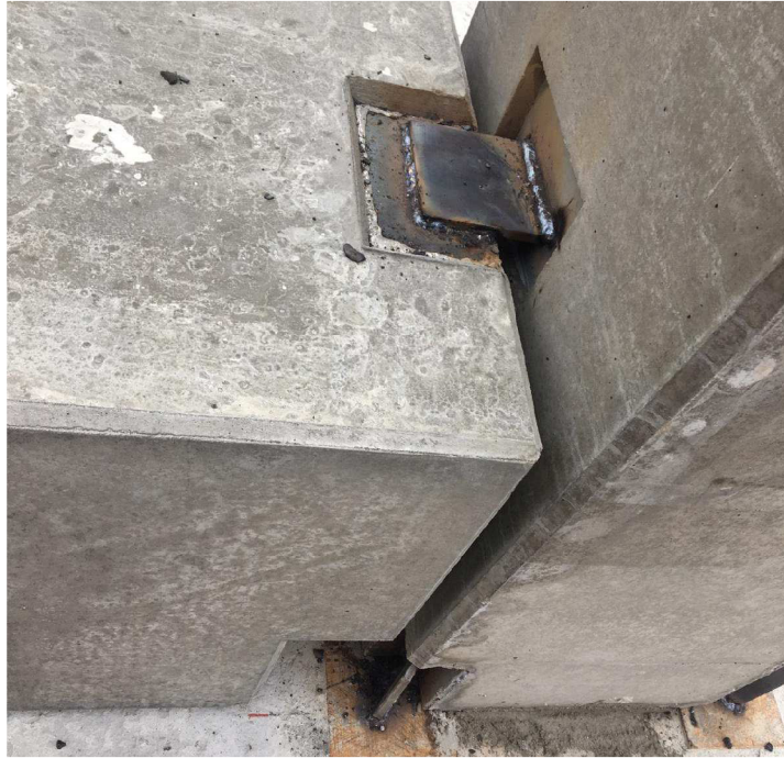
Obr.15, Přivaření základového prahu ke sloupu, autorské foto
