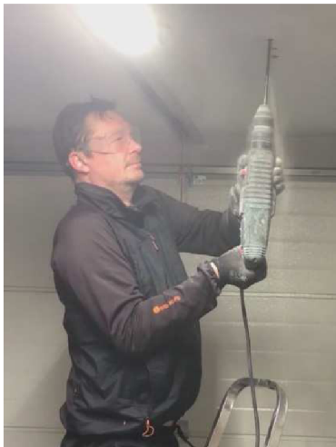
Obr.41, Vyvrtání otvoru, autorské foto
