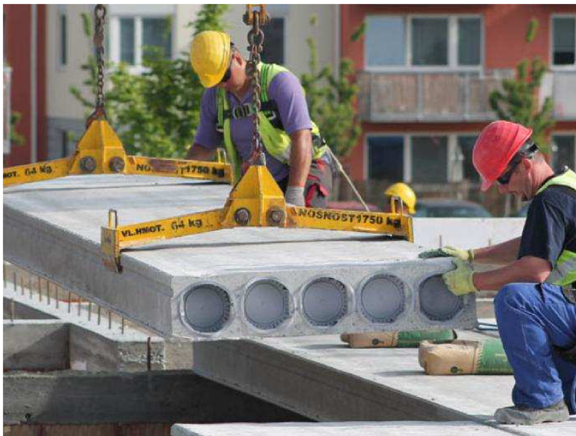
Obr.20, Umístování stropního panelu Spiroll, www.toposprefa.cz
