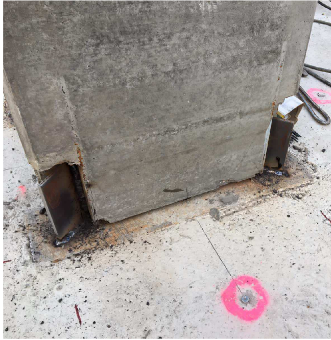
Obr.14, Navaření sloupu k patce, autorské foto
