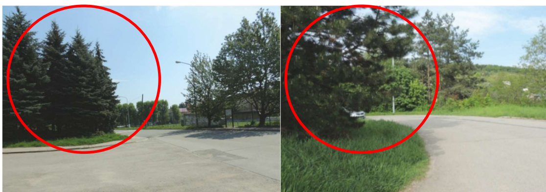
Obrázek 11 Zeleň brání v rozhledu v křižovatce a ve směrovém oblouku 54
