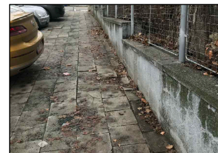
Narušení dopravní infrastruktury kořenovým systémem stromu
