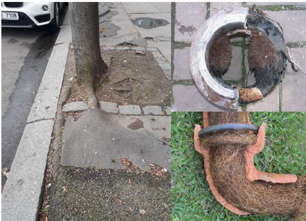
Obrázek 16 Narušení městské infrastruktury kořenovým systémem 62
