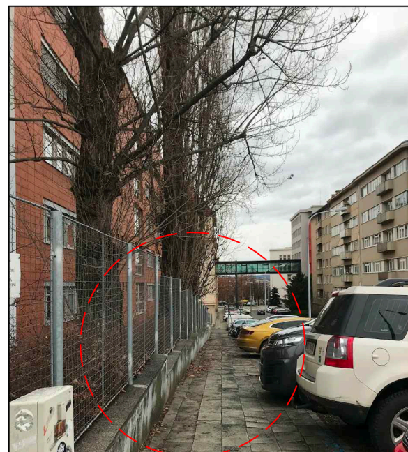
Narušení dopravní infrastruktury kořenovým systémem stromu
