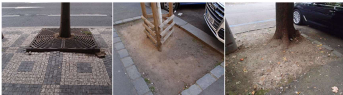
Obrázek 17 Nedostatečný přístup vody do stromové mísy 63
