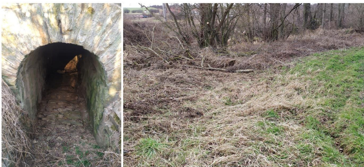
Obr. 22 – ZP4 na vtoku do propustku pod II/398 (vlevo) a ZP3 na vtoku do recipientu (vpravo), (zdroj: vlastní)
