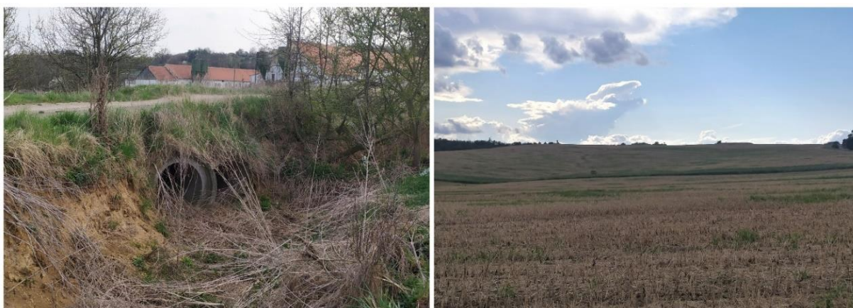
Obr. 17 – KP1=KB1 na vtoku do propustků (vlevo) a pohled z KP1=KB1 na sběrné povodí P1 (vpravo), (zdroj: vlastní)
