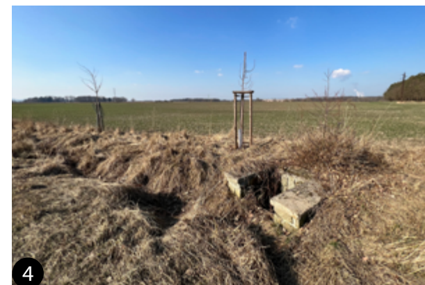
obr.č. 16 - Pozůstatky odvodnění pozemků
