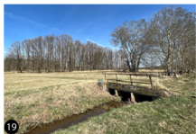
obr.č. 28- Betonový mostek přes odpad z Volešku zdroj: autorka práce
