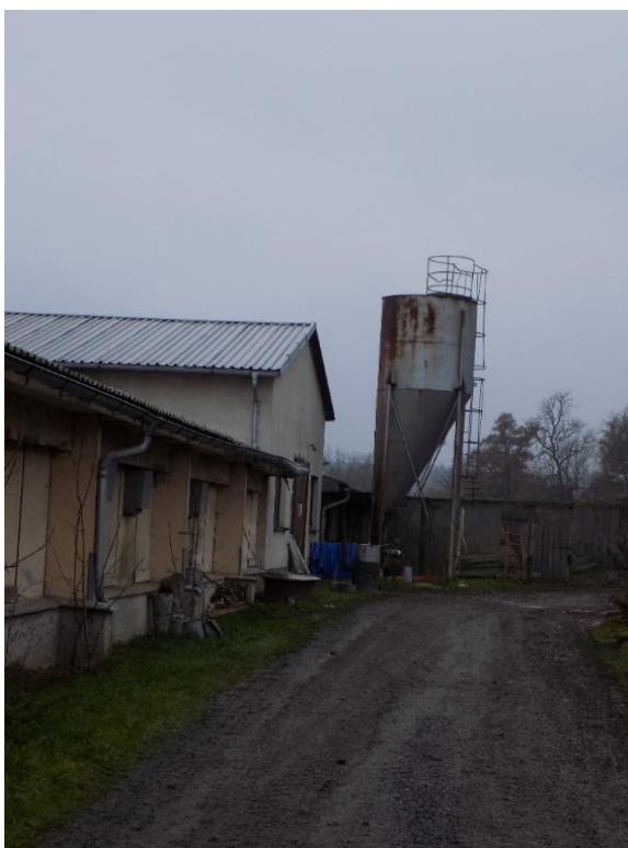
Obrázek č. 25 – Silo (zdroj: autor)
