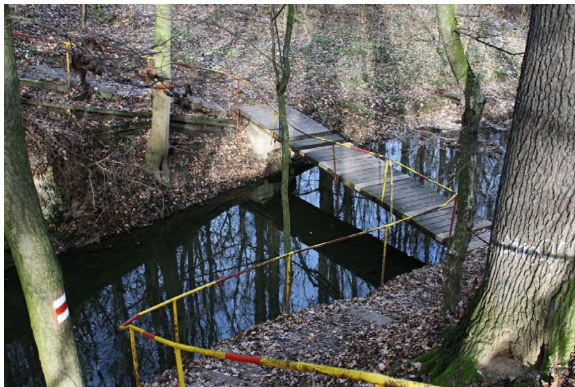
Obr. 12: lávka přes Říčanku (20. 1. 2018)
