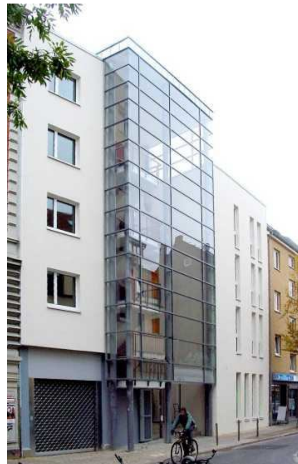
Pasivní bytový dům, Hamburg
