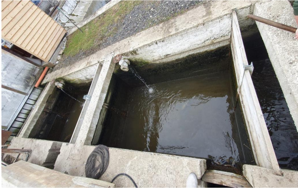
Obrázek č.23 – Pokusné zemní haltýře, ve kterých probíhaly praktické provozní experimenty na sádkách v Rožmitále pod Třemšínem. Na fotografii lze vidět spuštění hladiny vody na \frac{1}{2} před druhým experimentem ( vlastní zdroj ).
