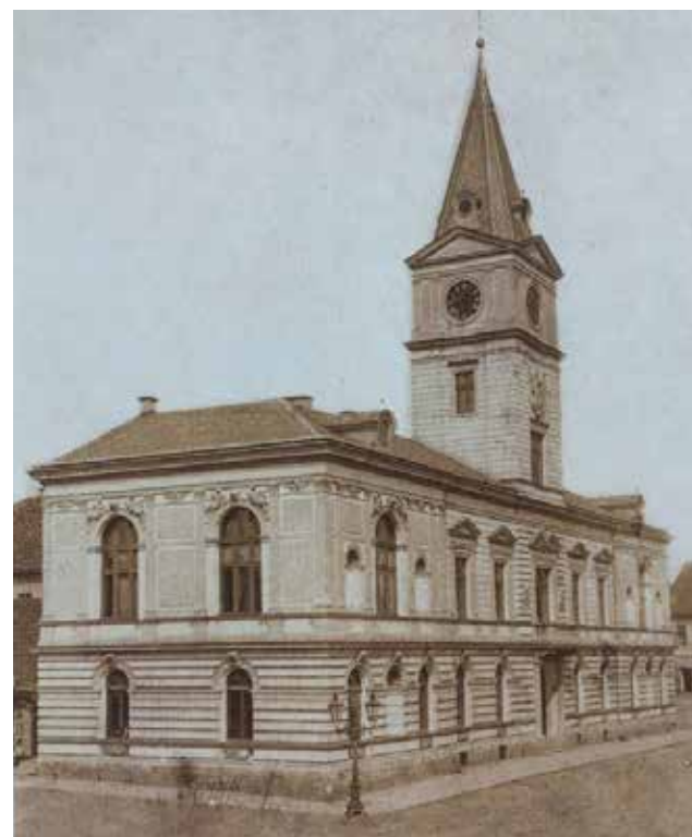
Obr. č. 19, Nová radnice, postavená v duchu jednoho z historizujících slohů, vystřídala starší budovu z poslední třetiny 18. století zdroj: Muzeum města Mnichovo Hradiště
