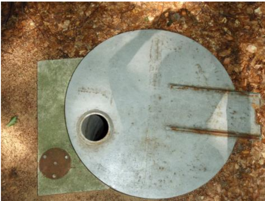
Obr. 2.6: Vstupní poklop do komínu [7]
