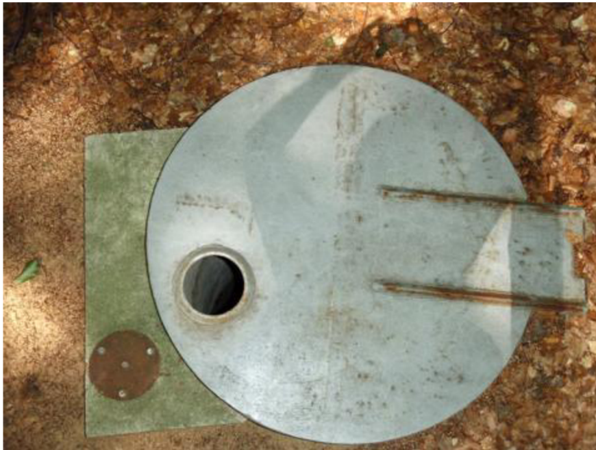
Obr. 2.6: Vstupní poklop do komínu [7]
