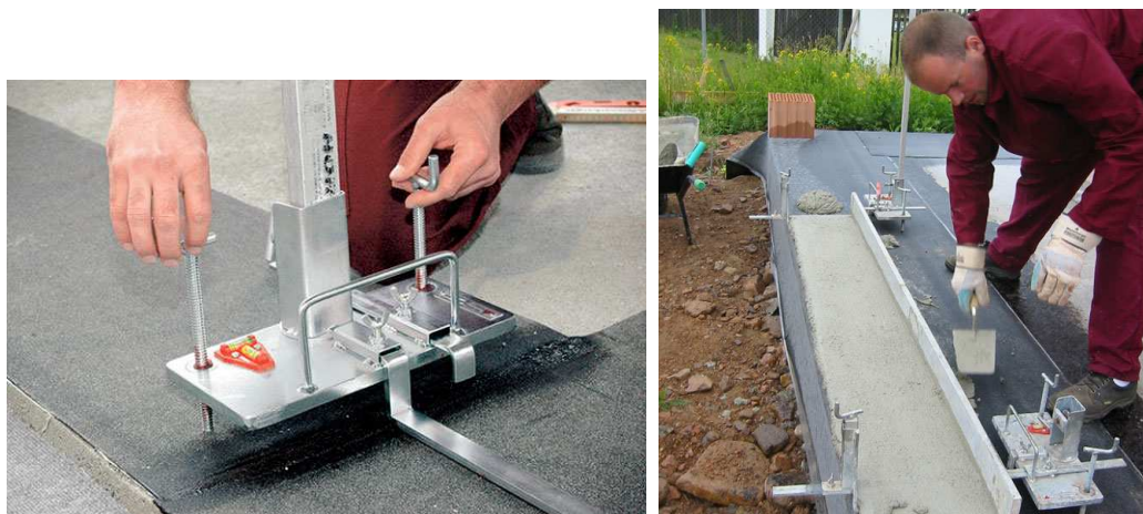
Obr. 9.2.7 Ukázka provedení vyrovnávacího, maltového lože (převzato z [11] )
