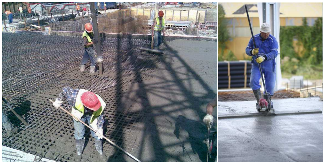
Obr. 9.1.7 Ukázka ukládání betonu a práce s vibrační latí (převzato z [4,5] )
