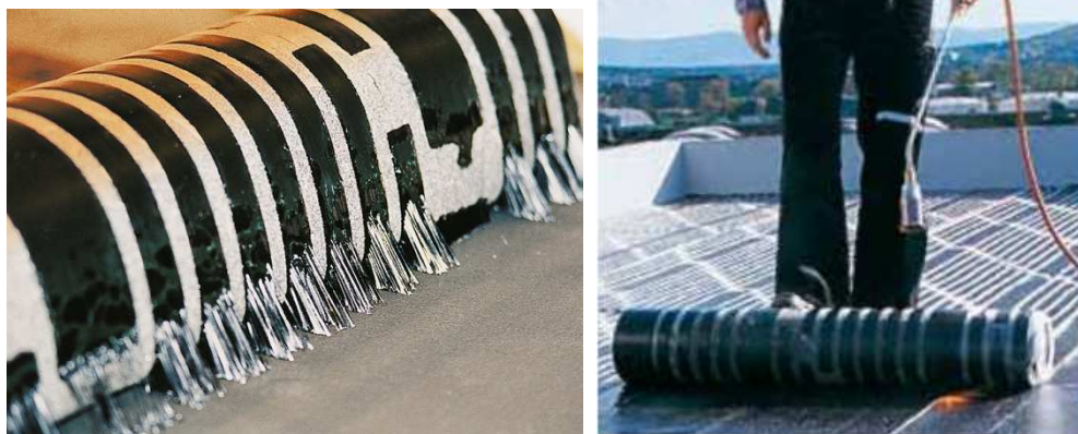
Obr. 9.2.12 Ukázka natavení lepících pruhů (převzato z 15,61 )
