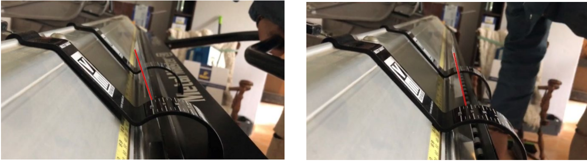
Obr. 26) Poloha plechu před uvolněním ohýbací čelisti a po uvolnění čelisti (velikost ohybu 120^\circ ).
