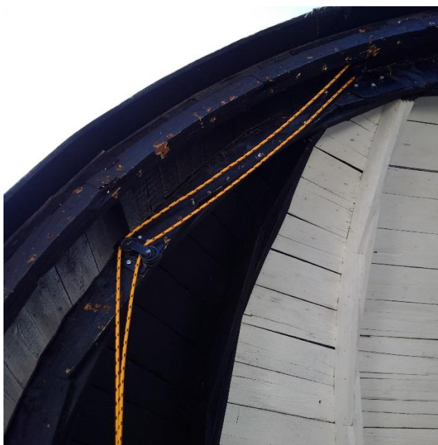
Obrázek 5: Kladkový mechanismus, kopule Antonína Bečváře
