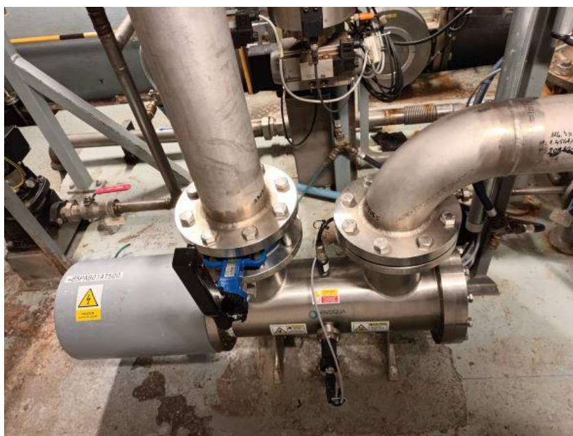
Obrázek 16 Instalace UV lampy na VE Mohelno (fotografie P. Čanda)
