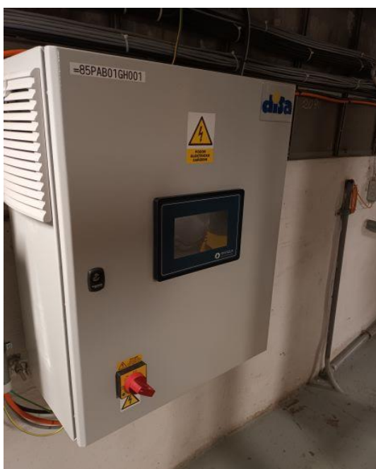
Obrázek 15 Řídicí panel UV lampy na VE Mohelno (fotografie P. Čanda)
