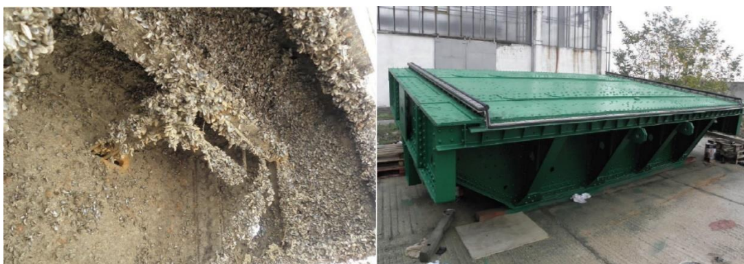
Obrázek 4: Aplikace antifoulingového nátěru na hradící Zdroj: Ježík (2014)
