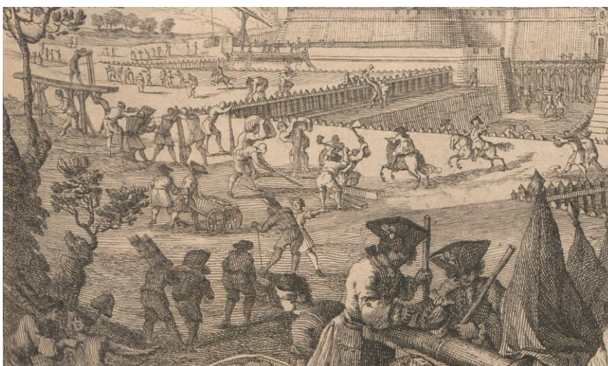
Vojáci během opevňovacích prací (BÉLIDOR, Bernard Forest de, La science des ingenieurs dans la conduite des travaux de fortification et d' architecture civile , https://echo.mpiwg-berlin.mpg.de/ECHODocuView?url=/mpiwg/online/permanent/library/M1R3K3S6&pn=6 , 10.10.2020)
