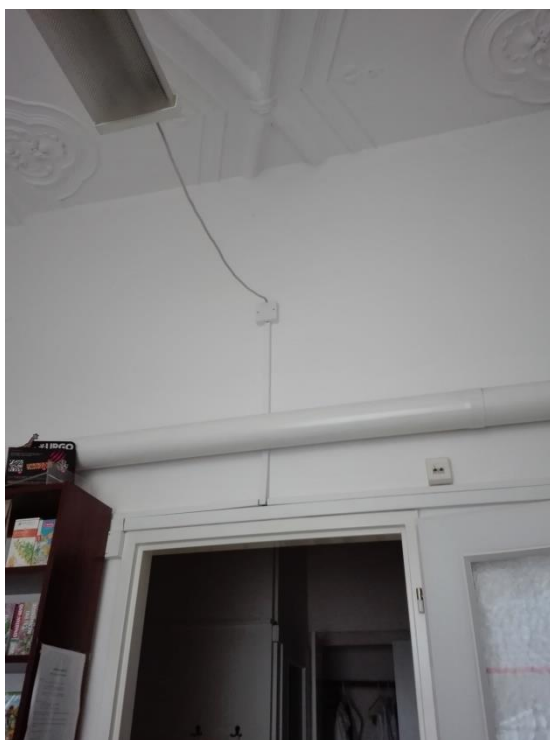
Příloha č. 12. Interiér polikliniky. Ukázka nevhodně rozděleného štukového stropu v zadních prostorách lékárny.
