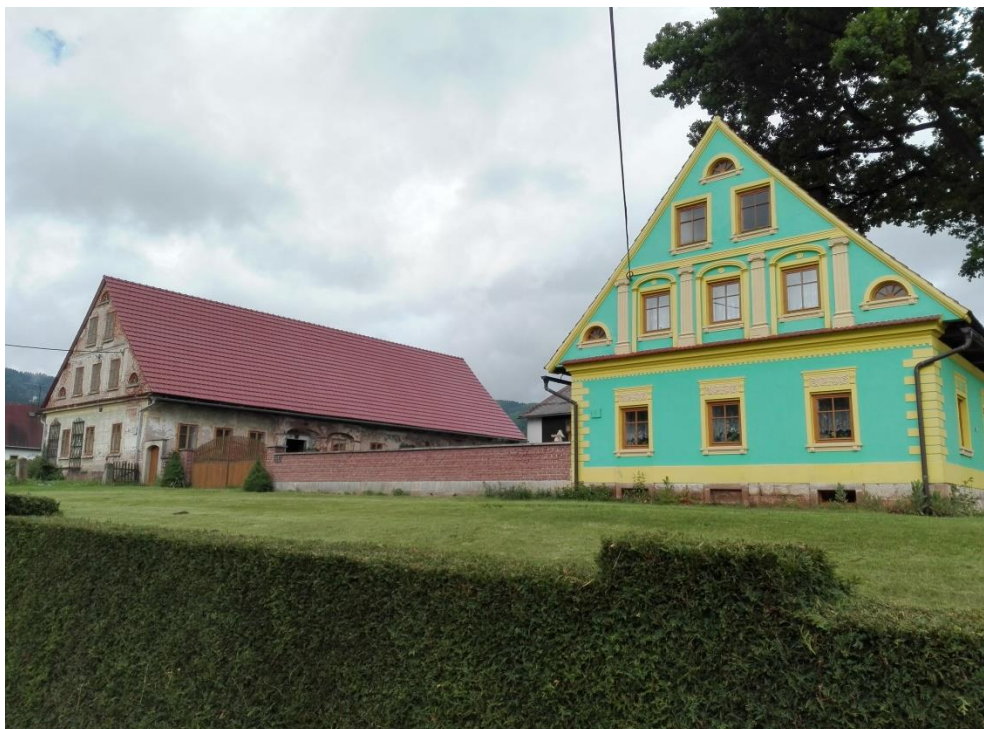
Příloha č. 45. Areál hospodářské usedlosti čp. 227 v Božanově.
