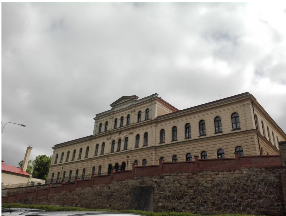
Příloha č. 3. Zbytky hradebního zdiva pod ZŠ Hradební v Broumově.
