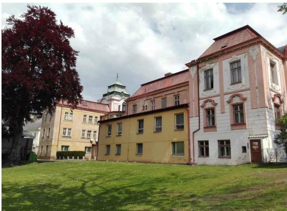
Příloha č. 11. Pohled na budovu polikliniky z ulice Střelnická.
