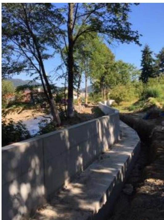
Obrázek 22: Ochranná zídka a berma na levém břehu řeky Desná (Jílková 2020).
