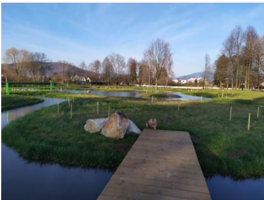
Obrázek 19: Zaplavené meandrující koryto a provedená revitalizace v povodňovém parku č. 1 (Jílková 2020).
