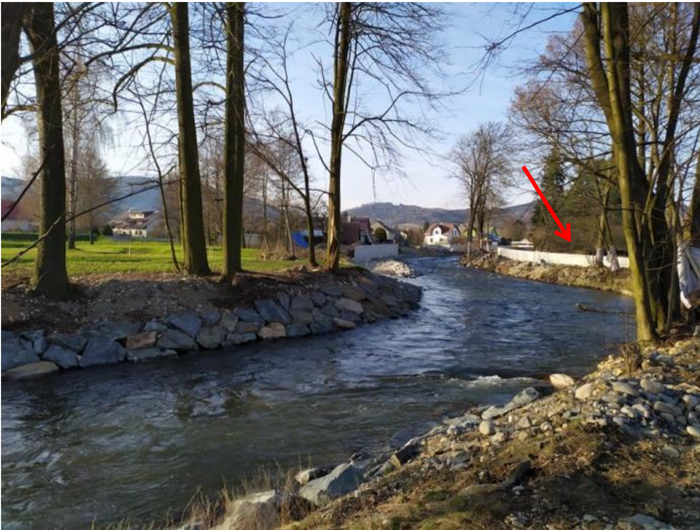
Příloha 22: SO 06 a 09 – Ochranná zídka na levém břehu řeky Desná v ř. km 14,449 – 14,650 (Jílková 2020).
