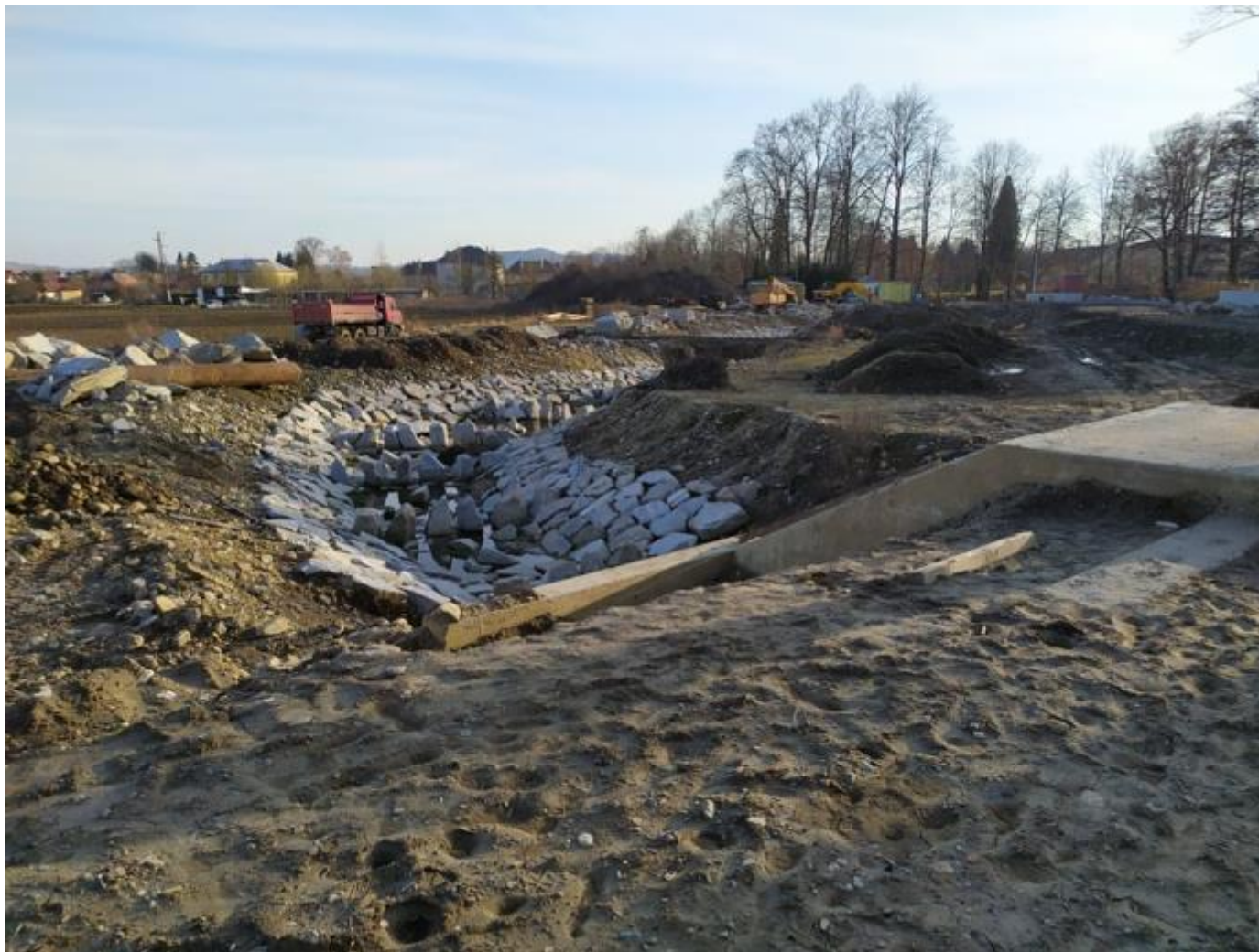
Příloha 23: SO 10.2 – Meandrovité koryto rybího přechodu (Jílková 2020).
