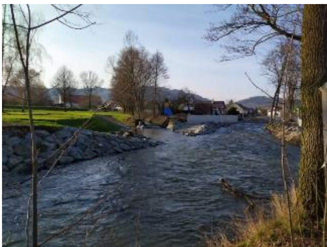
Obrázek 21: Ochranná zídka a berma na pravém břehu řeky Desné (Jílková 2020).
