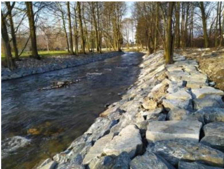
Obrázek 16: Vzhled kamenného záhozu s vyklínováním a urovnáním líce (Jílková 2020).
