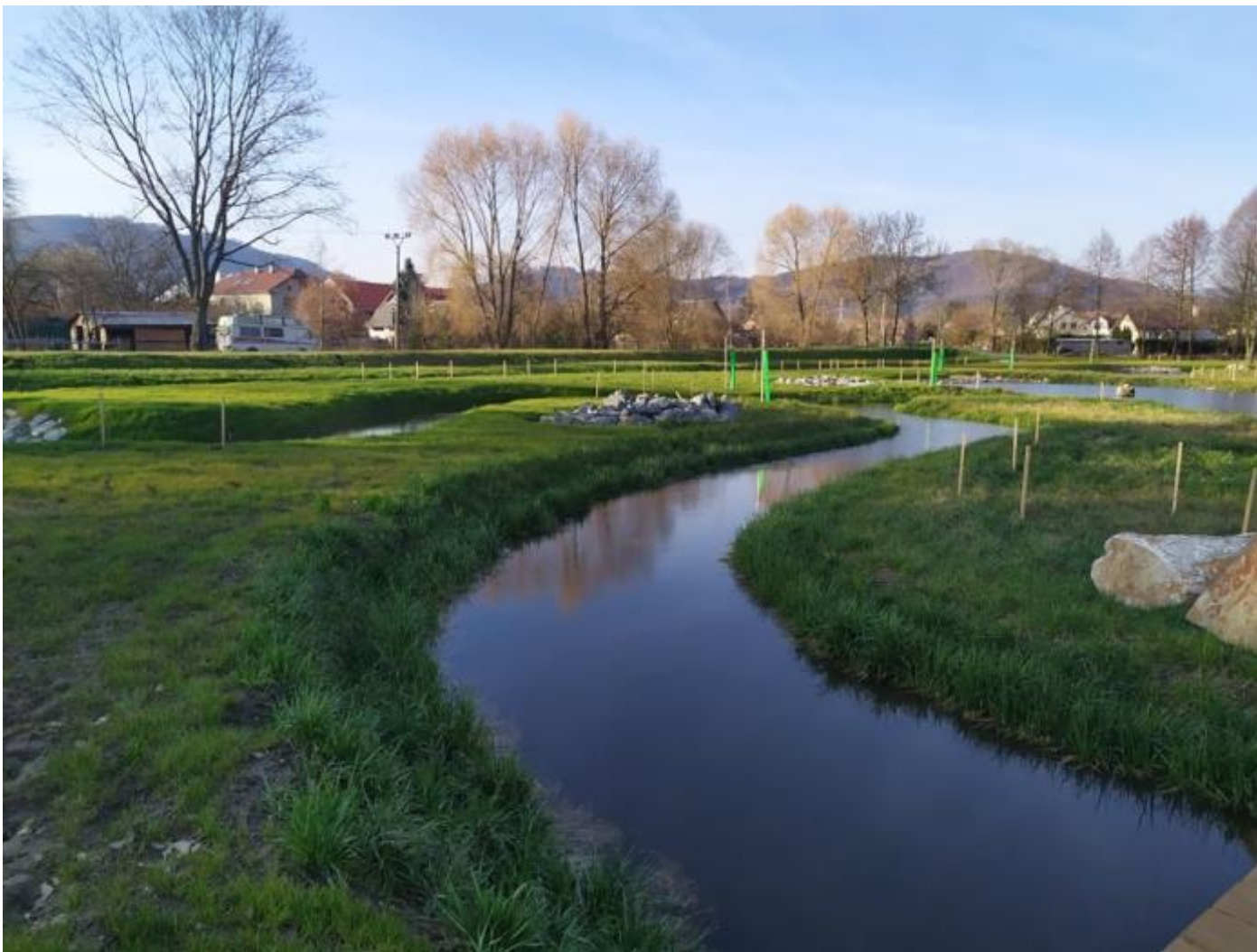
Příloha 20: SO 04 – Povodňový park č. 1 a odsazená ochranná hráz (v zadní části obrázku) SO 02 (Jílková 2020).
