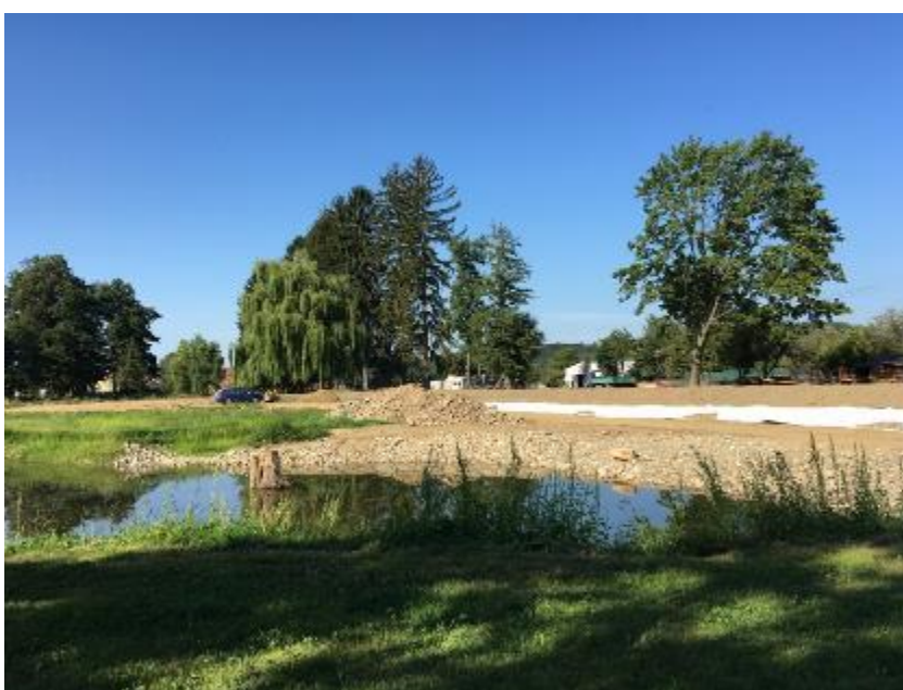
Obrázek 18: Odsazená ochranná hráz nad jezem (Jílková 2019).
