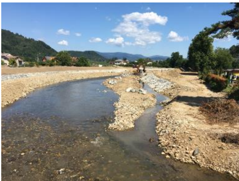
Obrázek 17: Prohrábka (zahloubení) koryta řeky Desná (Jílková 2020).
