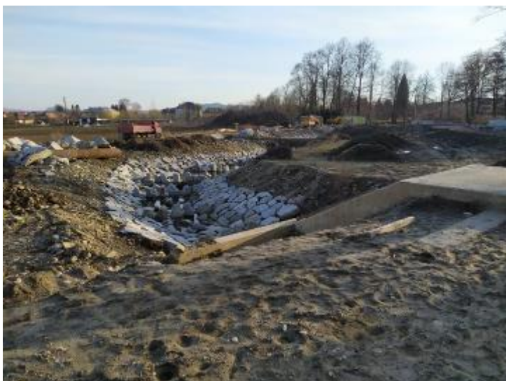
Obrázek 23: Meandrovité koryto rybího přechodu (Jílková 2020).
