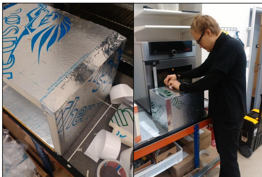
Obr. 37 Přelepování spojů pomocí hliníkové pásky (archiv autora, 2016)
