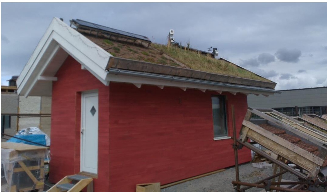
Obr. 26 Zkušební buňka v centru AdMas, Fakulta stavební (archív autora, 2016)
