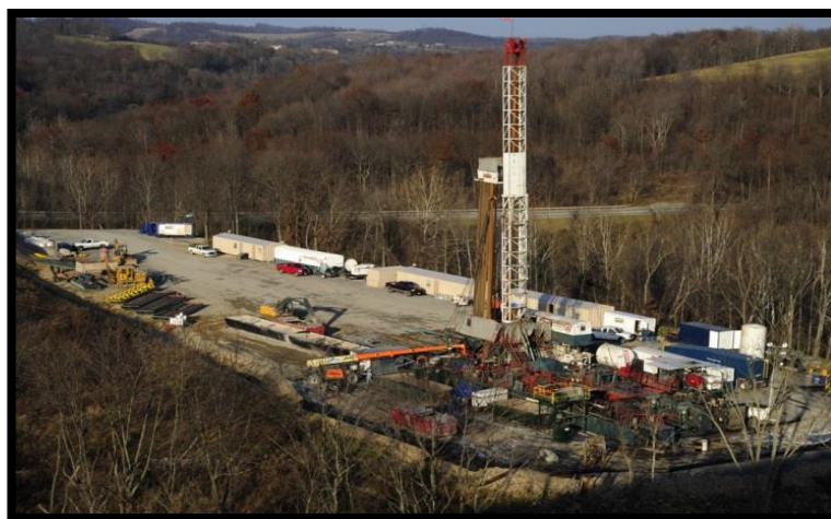
Obrázek č. 2: Těžební věž pro získání břidlicového plynu.
