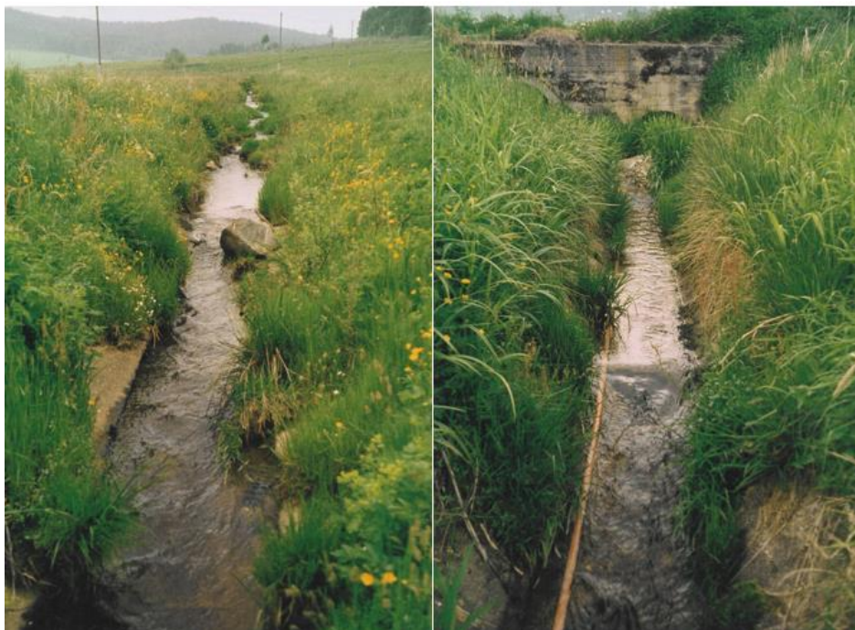
Příloha 9: Sviňovická strouha před revitalizací nad mostkem cesty k ústí Zbytinského potoka a pod mostkem – zřetelné je opevnění betonovými panely ve dně i bocích koryta, zdroj: Simon.
