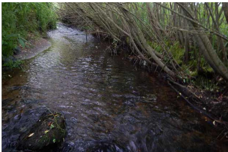
Příloha 17: Stav haťošterkových válců na Zbytinském potoce 10 let po založení (800 m. n. m.), čistý průtočný profil, mladé kmínky jsou vzpřímené, oprava nadměrné eroze pomocí haťošterkového válce byla provedena v roce 2006, zdroj: Simon et al., 2018.
