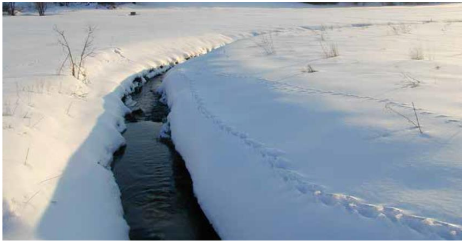
Příloha 8: Stav koryta Zbytinského potoka v roce 2003. Koryto toku je napříměné, zahloubené cca 1 m pod terén a celoplošně opevněné betonovými deskami, zdroj: Kučera.
