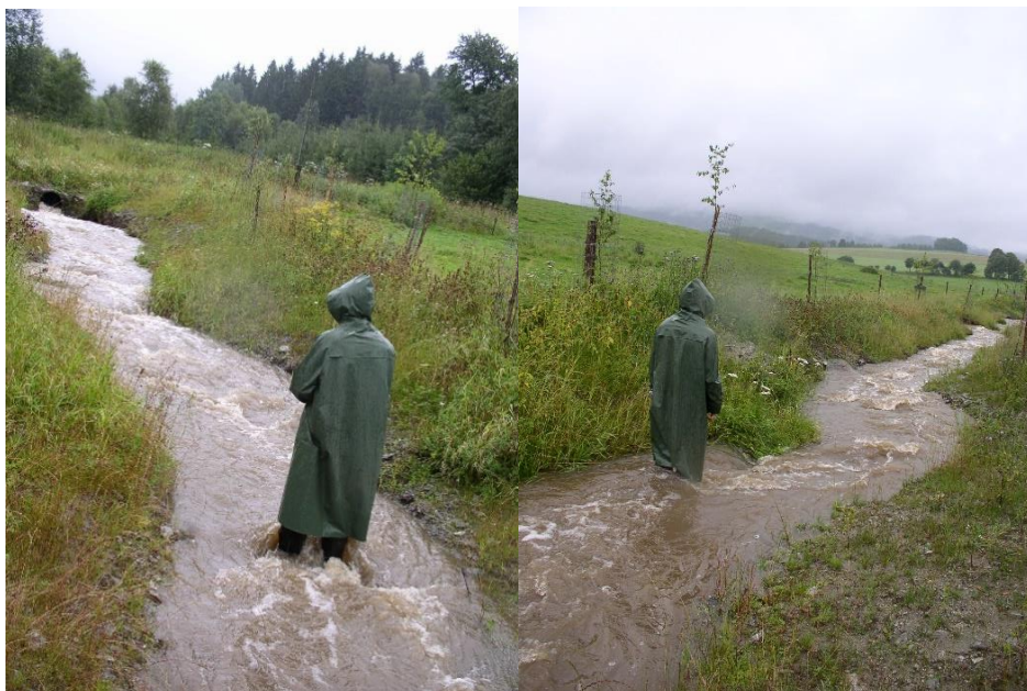
Příloha 12 b: Eroze širokého a nepřirozeného kapacitního koryta a dosud nestabilizovaného koryta, která vznikla vlivem bouřkových průtoků 16.8.2005 - v místě Sviňovická strouha nad revitalizací, zdroj: Simon et al., 2018.
