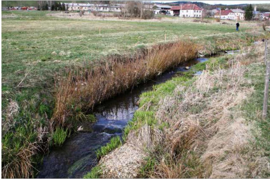
Příloha 13 c: Zbytinský potok – zpevnění erodujícího koryta haňošterkovými válci – obrostlý haňošterkový válec po první vegetační sezoně jaro 2008, zdroj: Simon.
