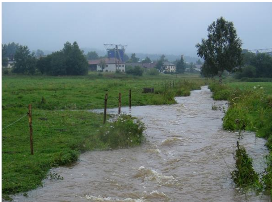
Příloha 12 a: Eroze širokého a nepřirozeného kapacitního koryta a dosud nestabilizovaného koryta, která vznikla vlivem bouřkových průtoků 16.8.2005 - v případě Zbytinského potoka pod vsí. zdroj: Simon et al., 2018.
