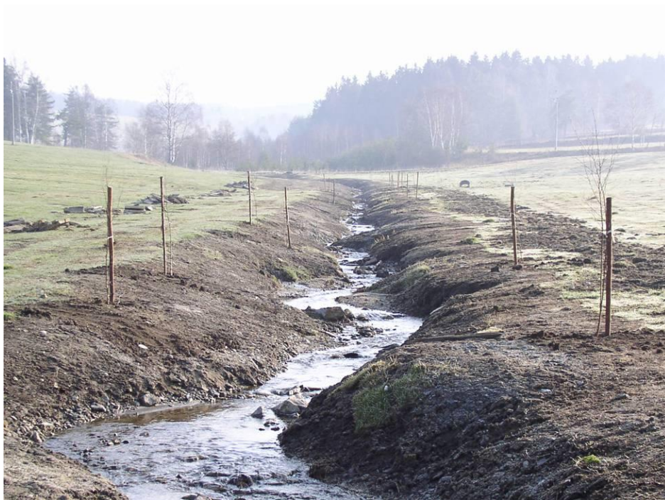
Příloha 11 a: Průběh revitalizace na Sviňovické strouze, nad silnicí a pod silnicí, stav těsně po dokončení v době výsadby stromů, zdroj: Simon et al., 2018.
