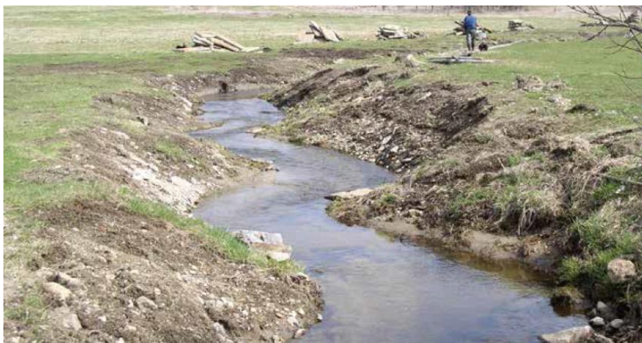
Příloha 10: Částečná revitalizace koryta Zbytinského potoka v listopadu 2004 – vytrhání betonového opevnění a naznačení meandrů, zdroj: Simon et al., 2018.
