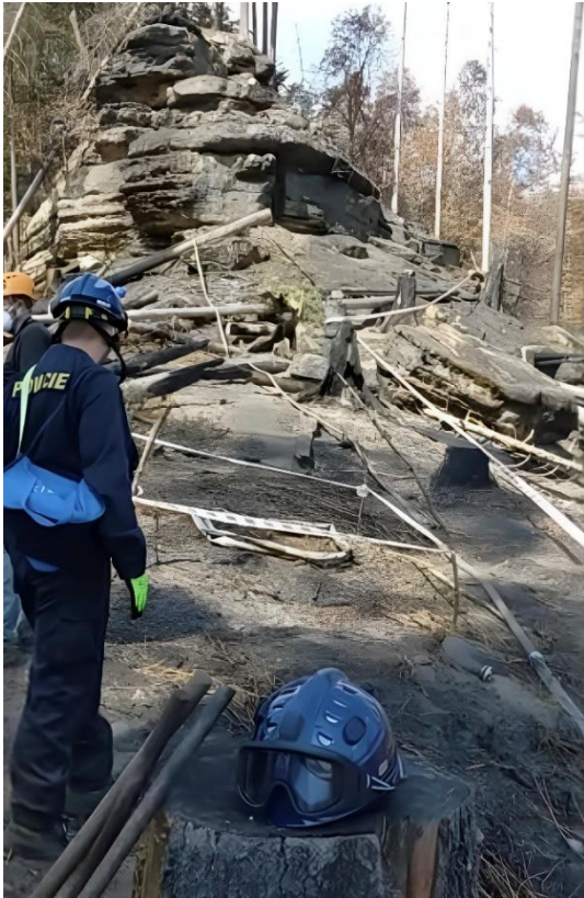
Obrázek I: Zajišťování stop v místě vzniku požáru 168
