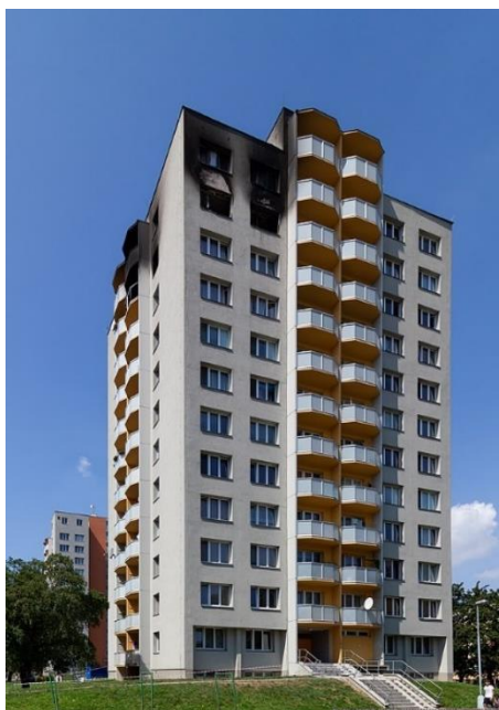
Obrázek 12: Požár bytu v Bohumíně. Zdroj: [16]
