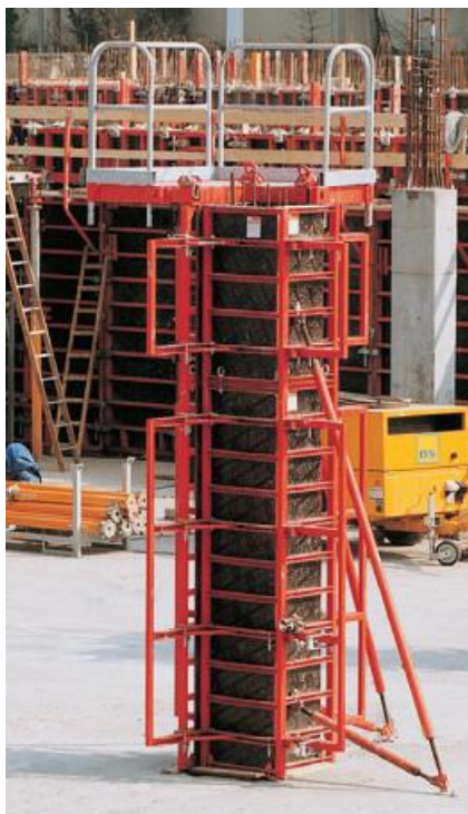
Obrázek č. 82 – Bednění sloupu 2 [37]
