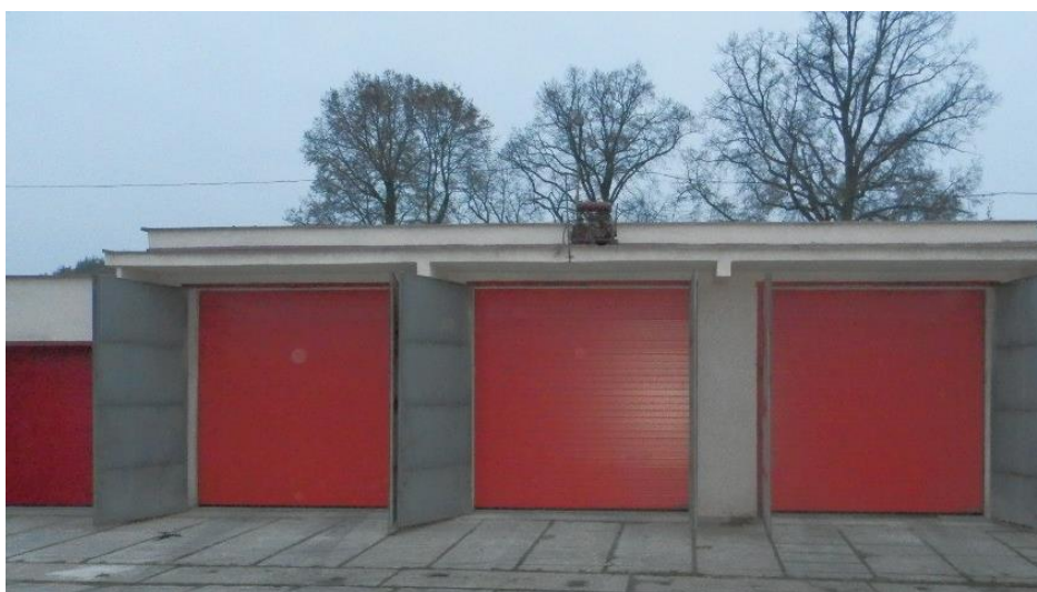
Obrázek 13 - Garážová vrata na hasičárně
