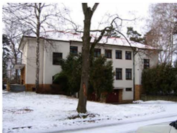
Správní budova – pohled od východu
