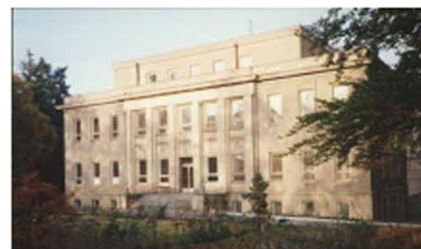
Hlavní budova nemocnice – pohled na původní stavbu (část A)
