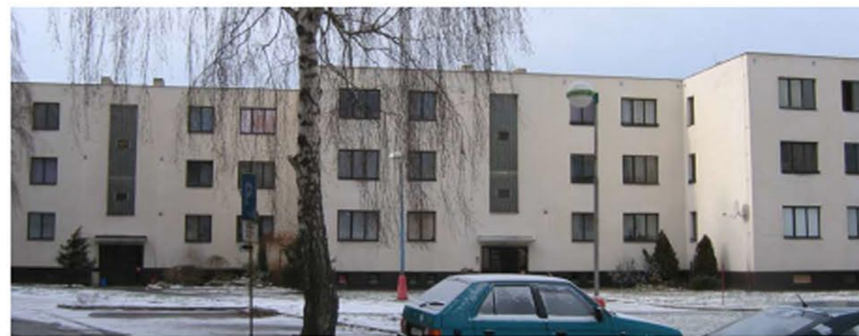
Bytový dům SO-20, čp. 1053, 1054, 1055 – pohled od východu
