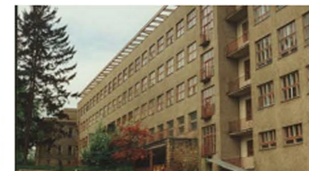
Hlavní budova nemocnice – přístavba z r. 1941 (části B,C)
