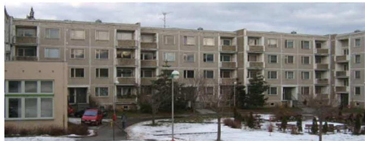
Bytový dům SO-22, čp. 1047, 1048, 1049, 1050, 1051 – pohled od jihu
