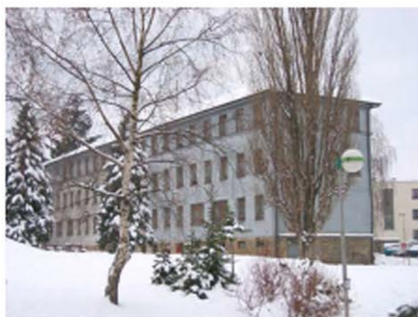
Stará ubytovna – pohled od východu
