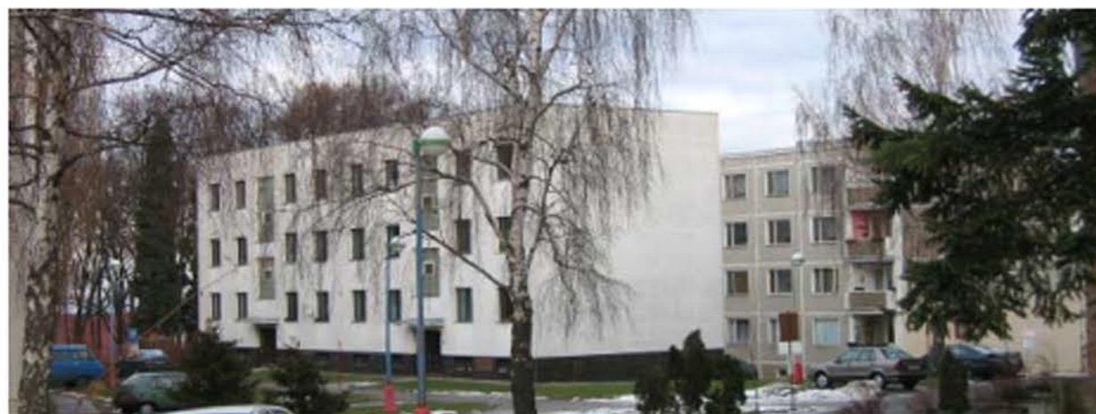
Bytový dům SO-21, čp. 1056, 1057 – pohled od vstupu do areálu
