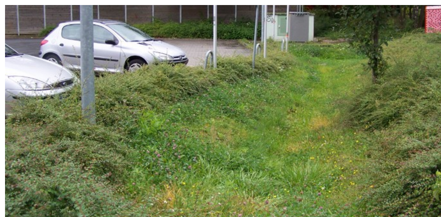
Obr. 22: Alternativou k „šedé“ infrastruktuře je i tento průleh na však dešťové vody z parkoviště, Berlín. (foto: Matěj Polánek).
