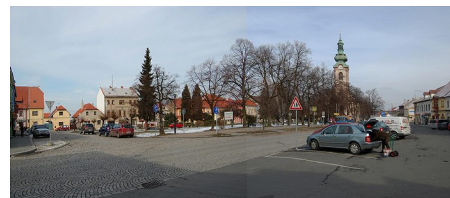
Obr. 37: Náměstí Smiřických v Kostelci ( https://stavbaweb.dumabyt.cz/architektonicka-soutz-obnova-namsti-smiickych-v-kostelci-nad-ernymi-lesy-9112/clanek.html )
