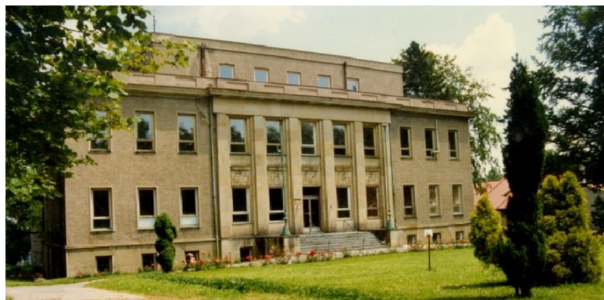
Obr. 46: parter staré budovy nemocnice po propojení s novou budovou a sjednocení fasád s použitím pískovce – místního tradičního materiálu.
