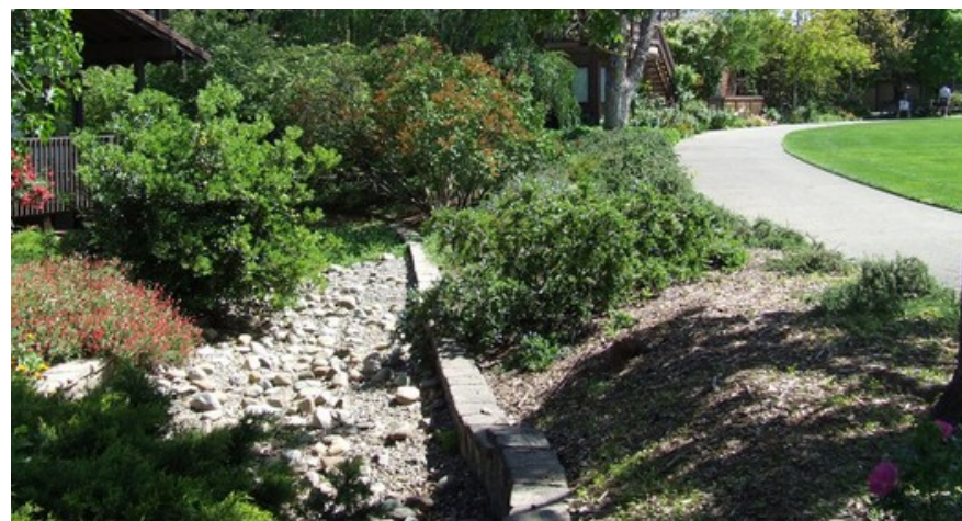
Obr.: Nenápadný průleh na vsakování dešťové vody. Jednoduché, levné a funkční řešení – Village homes, Davis, California (Cities of the future).
