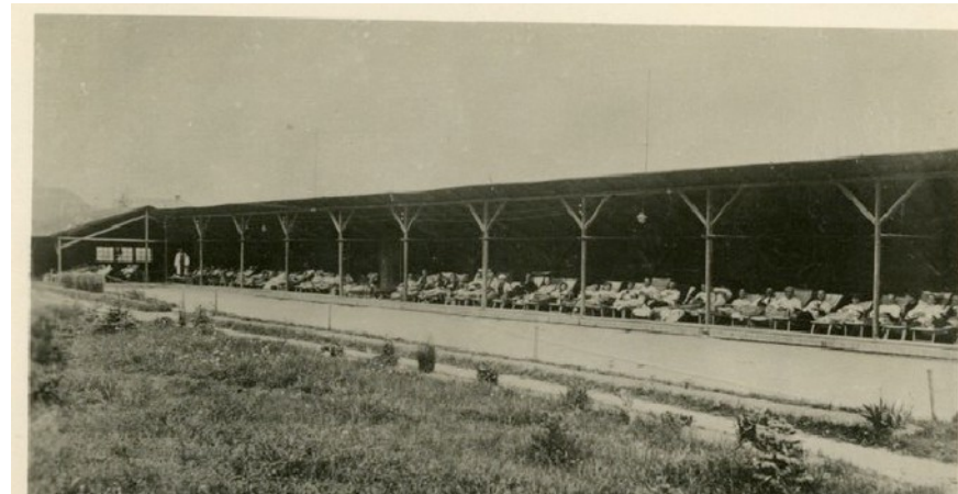
Obr. 47: V areálu léčebny vznikla několik leháren – tato nejstarší měla ještě lehkou dřevo-kovovou konstrukci a nacházela se v blízkosti nově založeného parku.
