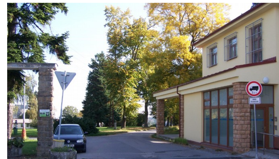
Obr. 56: Hlavní a jediný automobilový vstup do areálu od západu z ulice Kutnohorské. Budova vrátnice dnes slouží policii ČR. (foto: Matěj Polánek)
