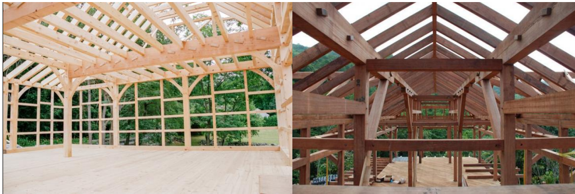
Obr. 4 Příklady použití roštového nosníku s nakloněnými příčnými hmoždíky klínového tvaru v současné dřevěné konstrukci (A) Tolland, Connecticut, USA; The Barn Yard and Great Country Garage 2019, (B) Costa Rica; Fire tower engineered timber 2019
