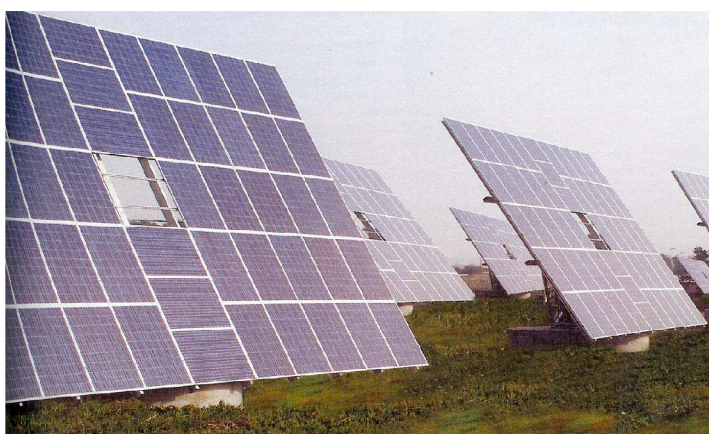
Obr. 9: Dvouosé natáčecí zařízení instalované v Richmondu, USA. Mezi technickými parametry je uváděno až 40 % zvýšení produkce elektrické energie a schopnost odolávat nárazům větru o rychlosti 177 km/h. [4]
