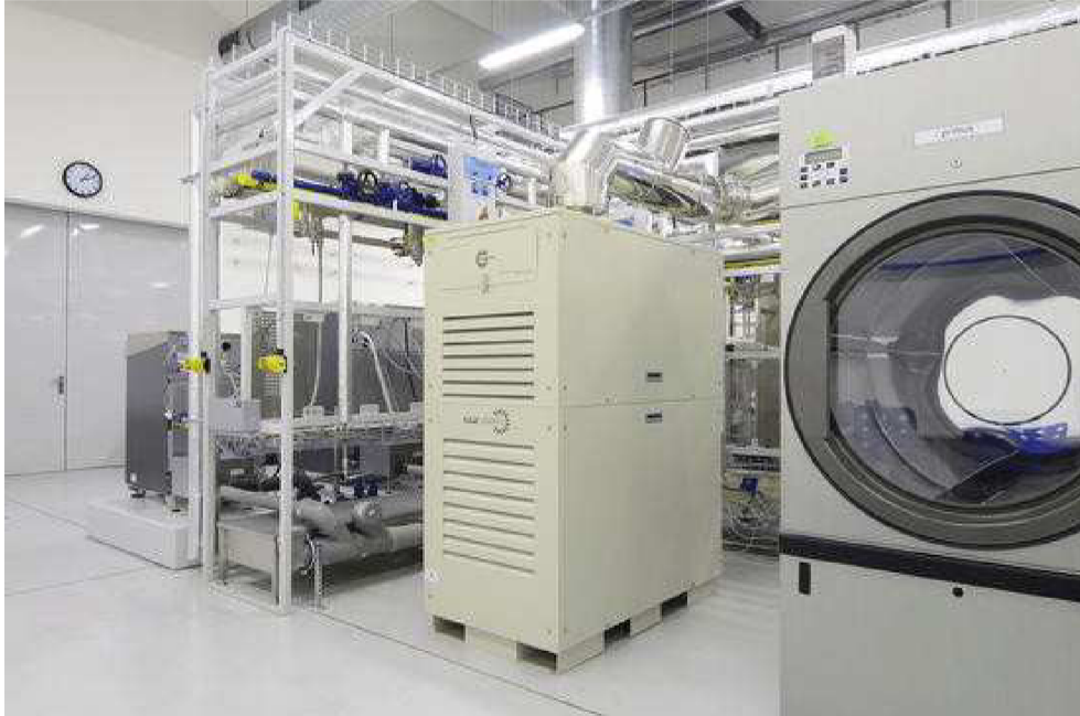
Obr. 1 Mikroturbína Capstone C30 integrována do infrastruktury LENP
