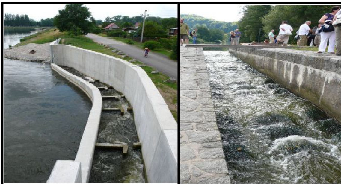
Zleva štěrbinový RP, Zprava kartáčový RP
