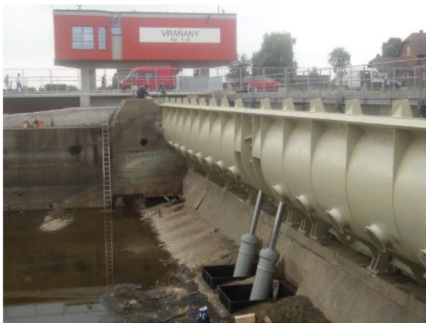
Obr. 15: Dutá klapka podpíraná hydromotorem (jez Vraňany) [23]
