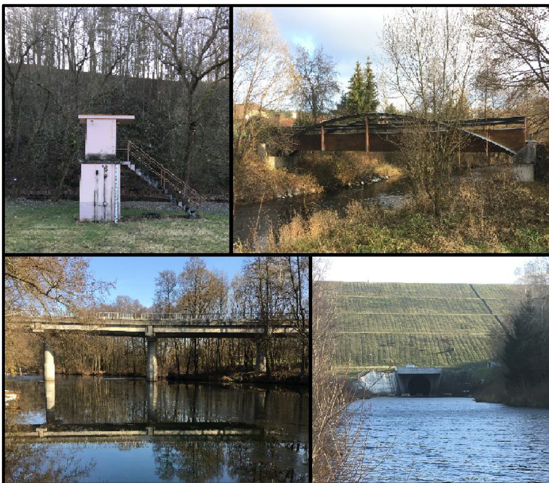
Limnigraf (vlevo nahoře), Lávka pro pěší (vpravo nahoře), Železobetonový most Soutice (vlevo dole), VD Švihov (vpravo dole)
