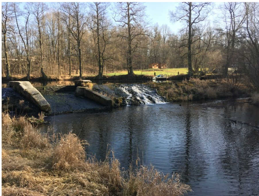
Obr. 9: Stávající konstrukce pevného jezu Soutice (T. Staněk 2020)
