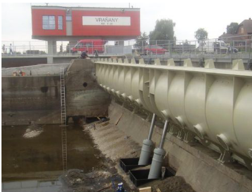
Obr. 15: Dutá klapka podpíraná hydromotorem (jez Vraňany) [23]
