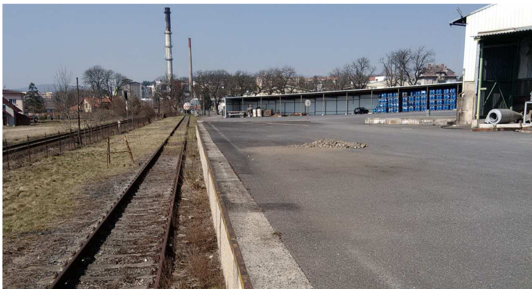
Obr.č. 18 Východní část areálu s nákladovou rampou vlečky
