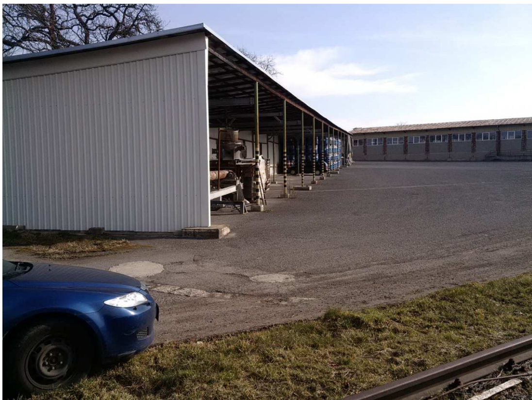
Obr.č. 11 Východní část areálu - plechový přístřešek
