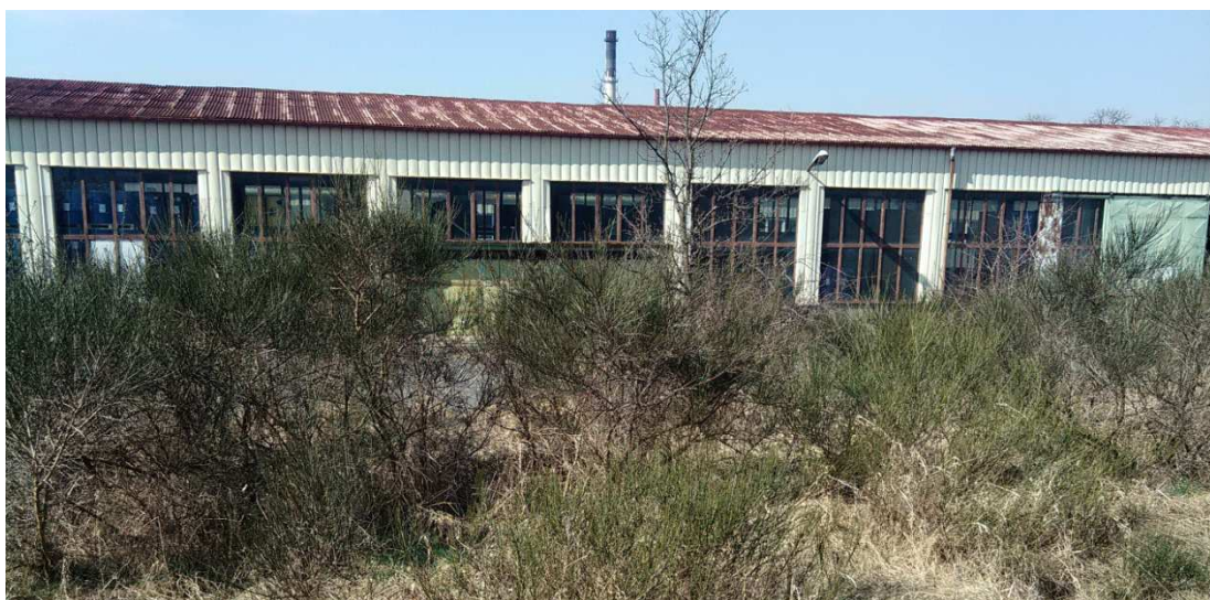
Obr.č. 12 Lesní pozemek s halou v pozadí
