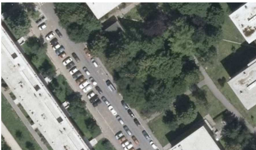
Obr. č. 73: Pohled na tzv. proseckou strkačku v ulici Jablonecká (zdroj dat: CUZK @ 2018)
