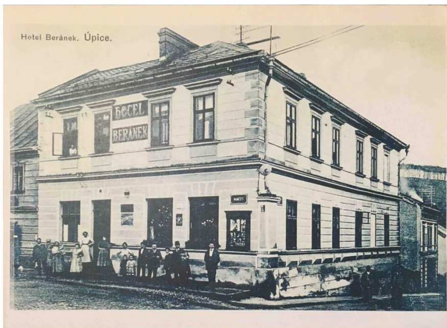
Příloha č. 8 – Budova úpického hotelu Beránek ve 30. letech 20. století.
