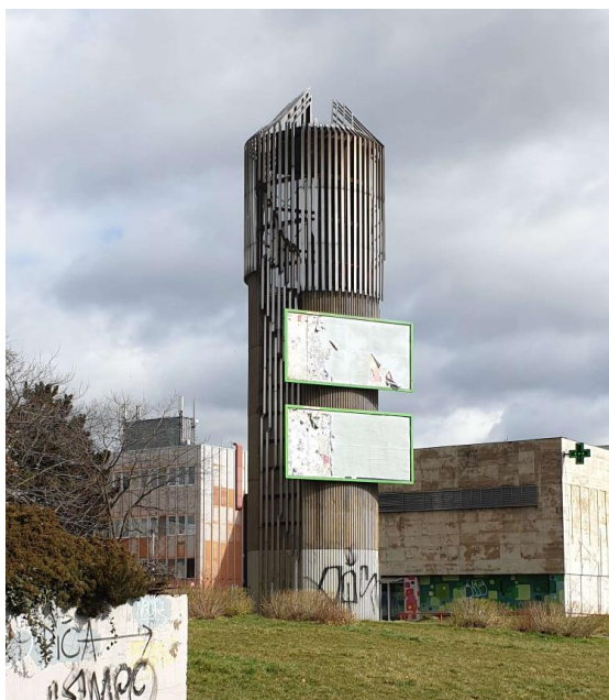
Obrázek 7 - Tubus Hlavního větrání pro stanic Háje
