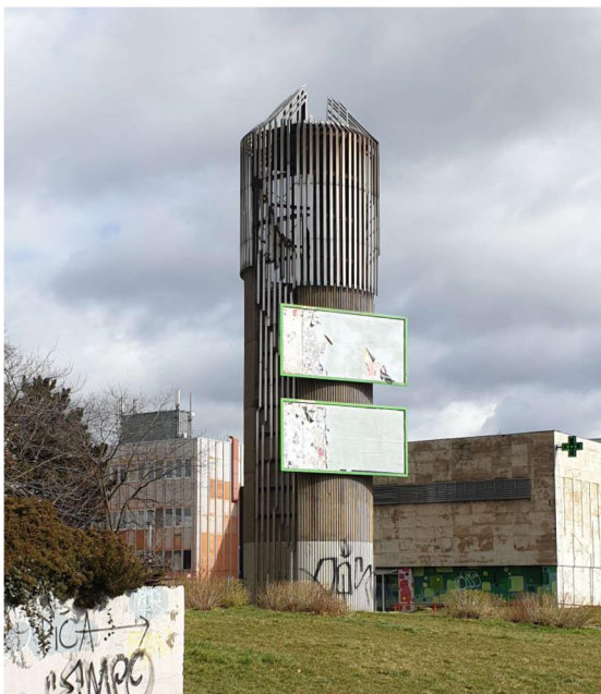
Obrázek 7 - Tubus Hlavního větrání pro stanic Háje
