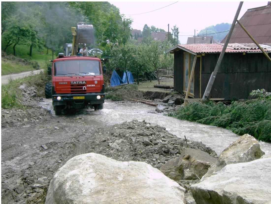
Příloha 13: Těžká technika při úpravách zájmových toků
