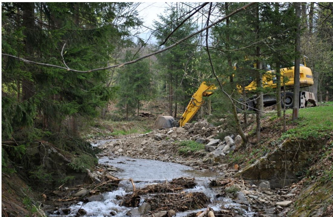
Příloha 14: Těžká technika při úpravách toku
