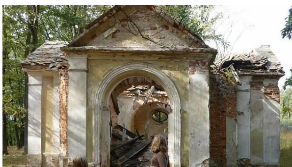
1. Kaplička před demolicí
