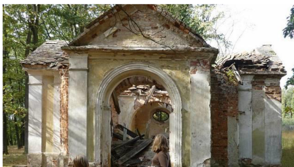
1. Kaplička před demolicí
