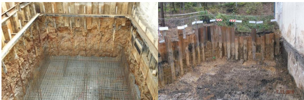
Obr. 10 – Zakládání stavební jámy a železobetonové jímky 26
