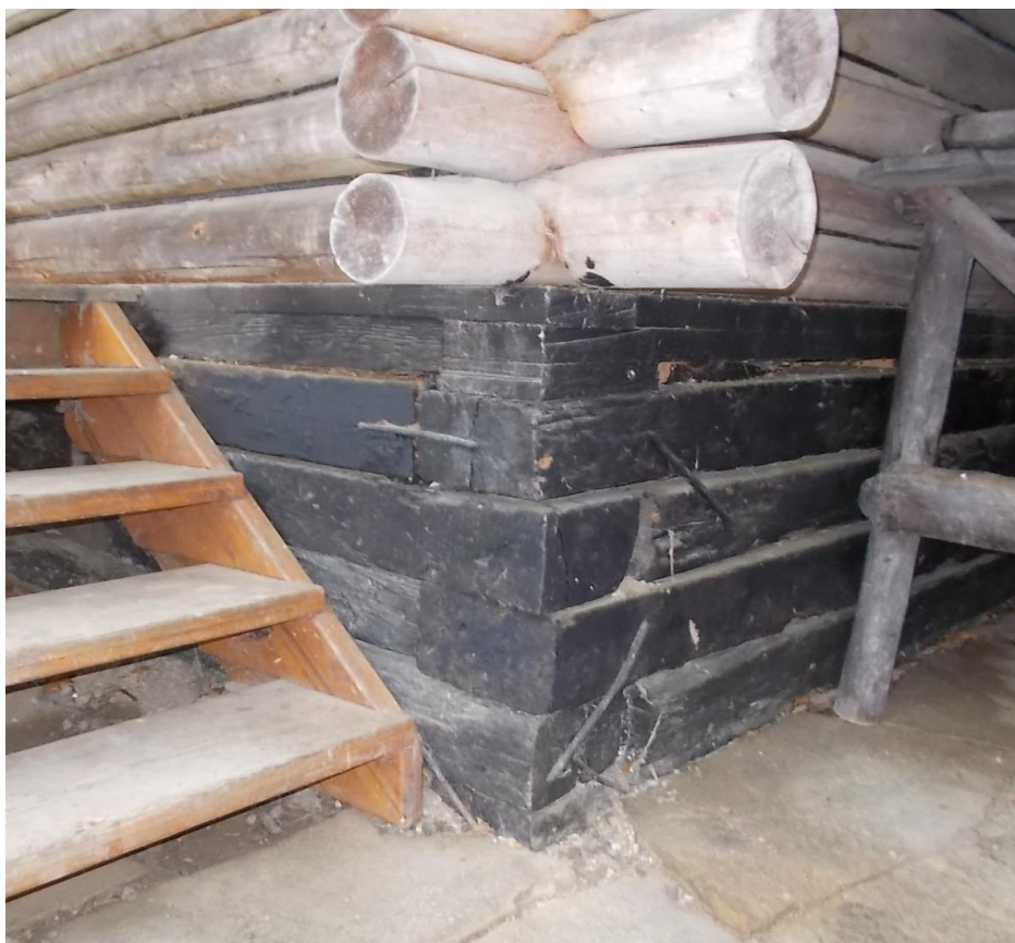
Oddíl TK Oregon Kolín p.s. – založení stavby
