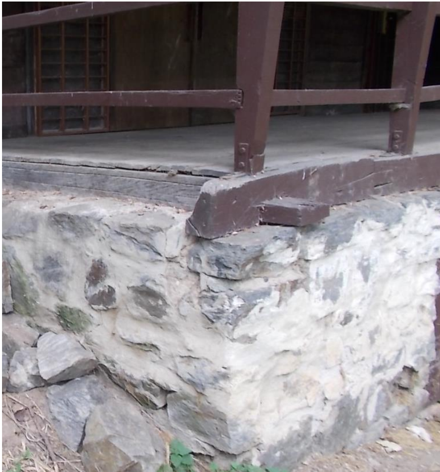
Oddíl Skauti Plaňany – založení stavby
