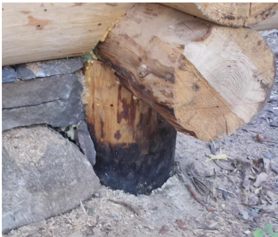
Spolek Samotáři Konárovice – způsob založení stavby
