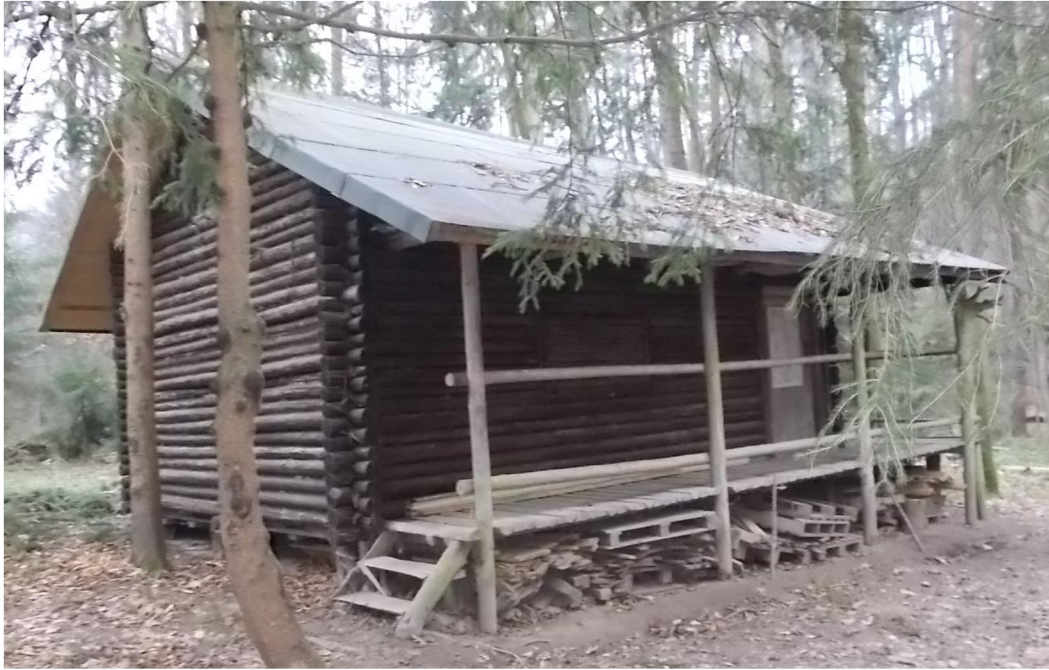
SO 01 Chata, pohled jihozápadní
