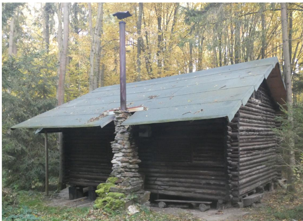
SO 01 Chata, pohled severní
