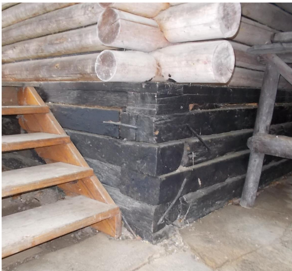
Oddíl TK Oregon Kolín p.s. – založení stavby
