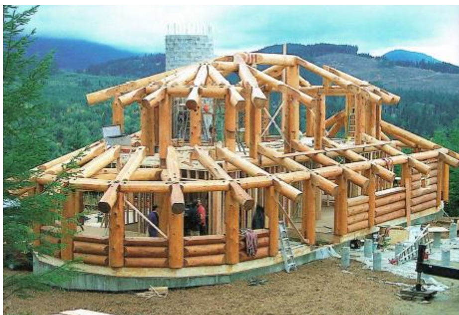
Obrázek 16 Systém piece-on-piece (Houdek 2011)
