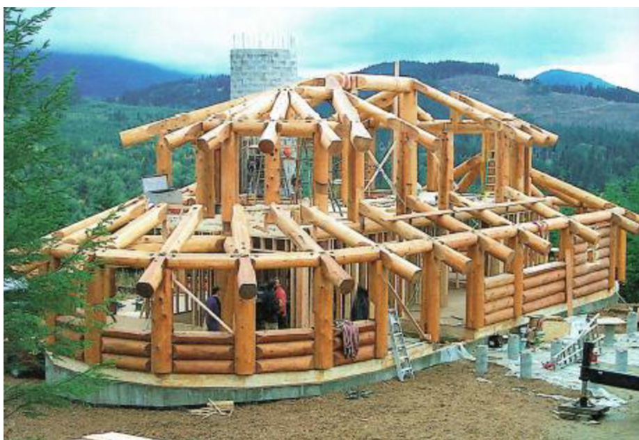
Obrázek 16 Systém piece-on-piece (Houdek 2011)
