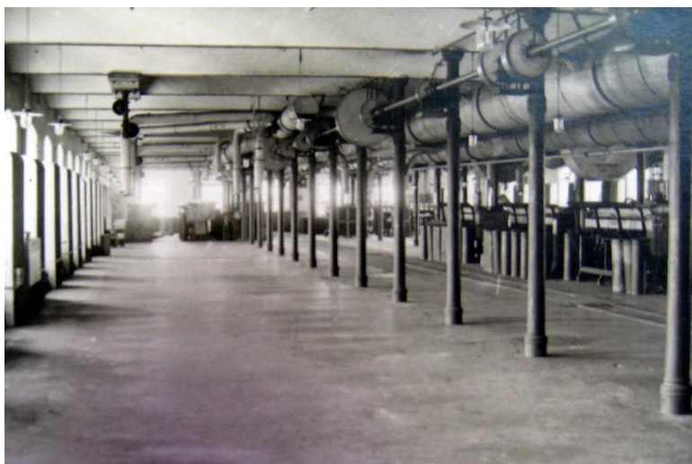
33) Přizemní hala ve Faltisově továrně.
