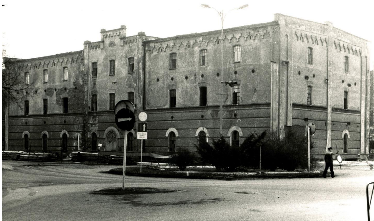
36) Budova skladu lnu v areálu Faltisovy továrny, fotografie z roku 1901.
