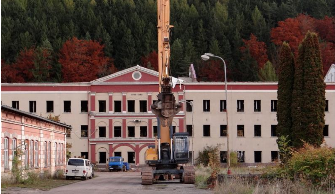
55) Klugeho továrna v Horním Starém Městě v průběhu demolicе.
